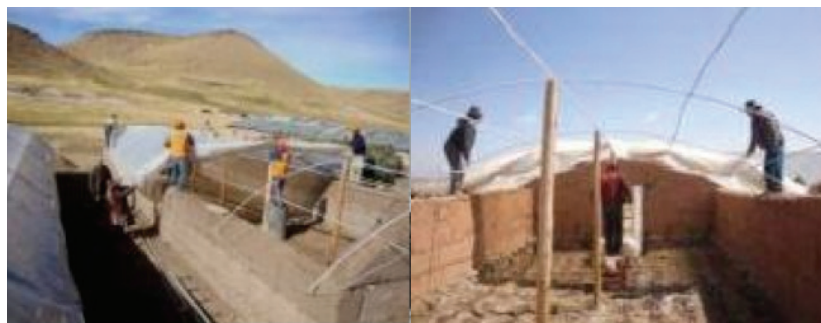
Foto de la construcción de los fitotoldos en Putaccasa. Foto tomada de la Fundación Integración Comunitaria. Consulta: 10 de agosto de 2015. http://fundacionintegracioncomunitaria.com/proyecto_8b.html
