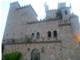
construccion atipica Mas de 3 niveles
