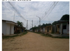
5. Jr. San Martín via afirmada en mal estado
